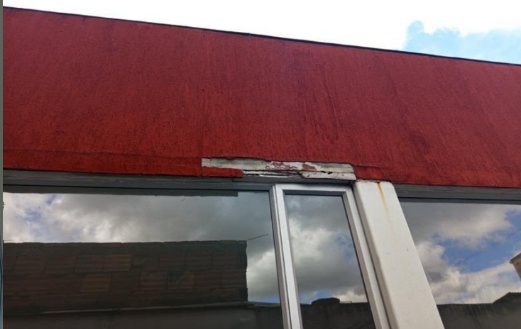
Humedad en el muro falso
